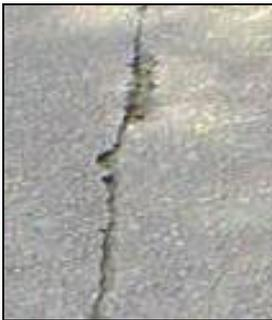
Figura 2: Esempio di fessurazione longitudinale
