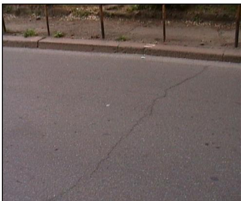
**Figura 10: Esempio di fessura trasversale**
