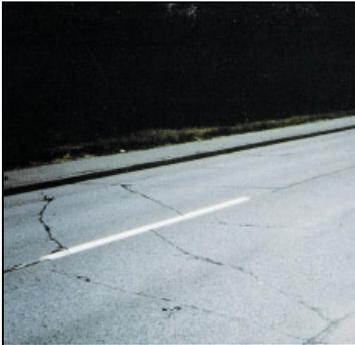
**Figura 3: Esempio di fessurazione trasversale**
