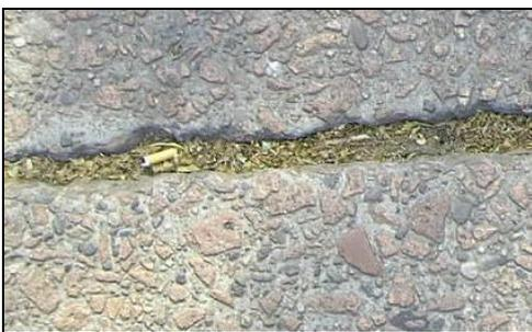
**Figura 4: Degrado dei giunti non sigillati**
