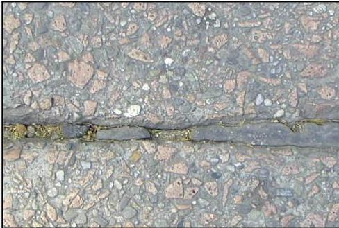
**Figura 5: Degradamento dei giunti precedentemente sigillati**
