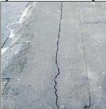
Figura 8: Esempio di fessura longitudinale
