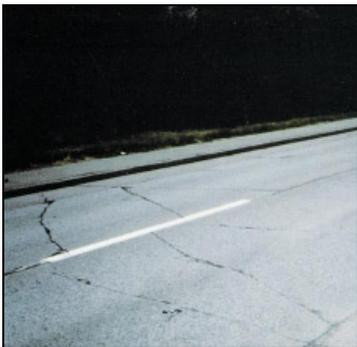
Figura 3: Esempio di fessurazione trasversale
