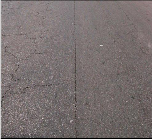
**Figura 11: Fessura longitudinale da giunto di stesa.**
