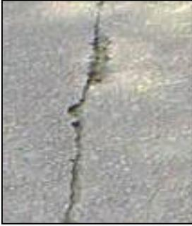
**Figura 2: Esempio di fessurazione longitudinale**
