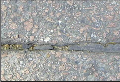
**Figura 5: Degrado dei giunti precedentemente sigillati**
