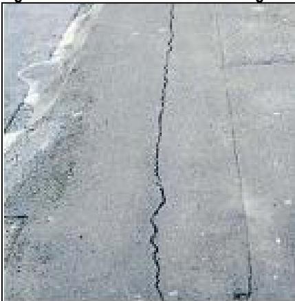
Figura 8: Esempio di fessura longitudinale
