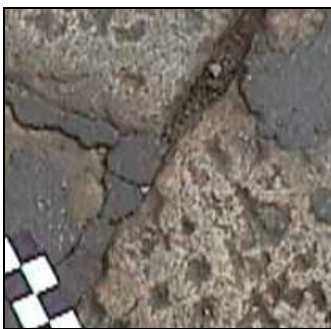
Figura 13: Asportazione di sigillante dai giunti
