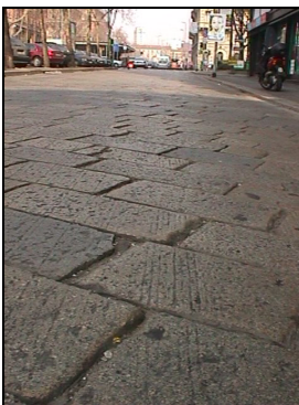
Figura 12: Eccessiva apertura dei giunti non sigillati
