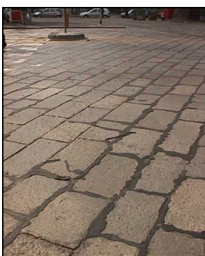
Figura 14: Spandimento di legante sul massello
