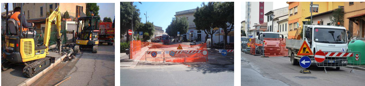
Figura 10: mezzi di cantiere
