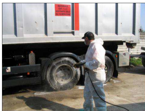
Figura 14: interventi per limitare diffusione polveri
