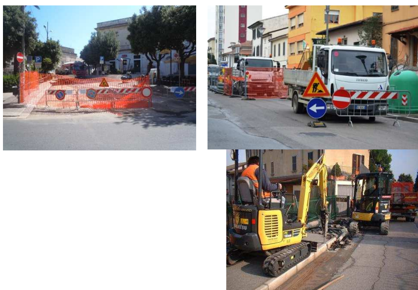
Figura 10: mezzi di cantiere
