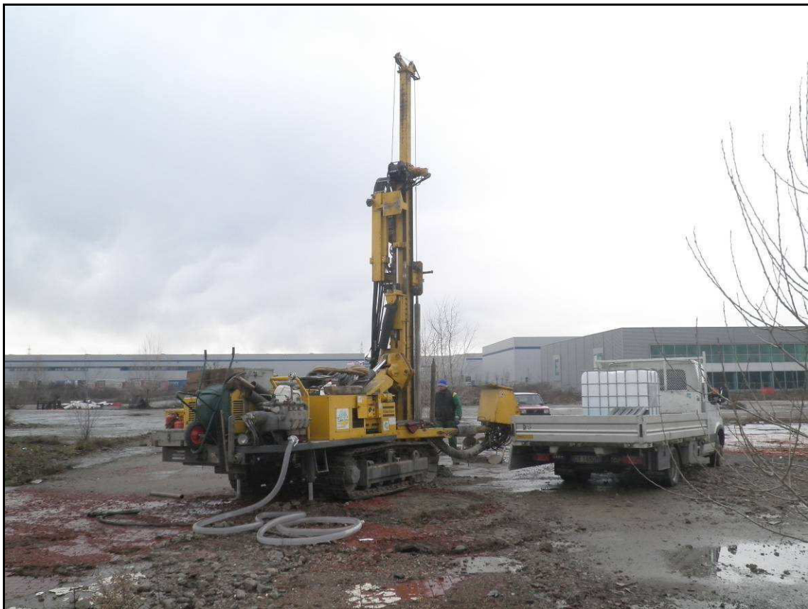
Postazione sondaggio S2.
