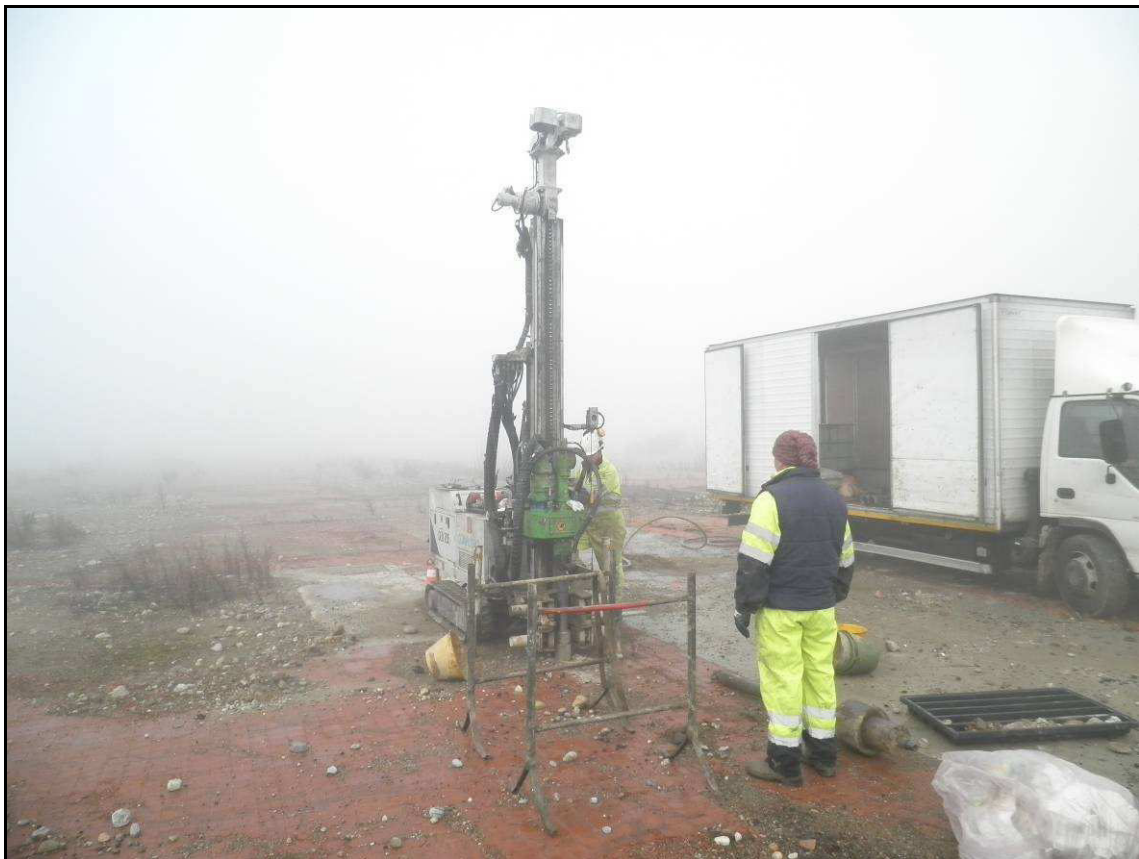
Postazione sondaggio S8.
