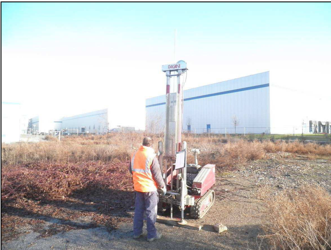
Postazione prova penetrometrica DP11.
