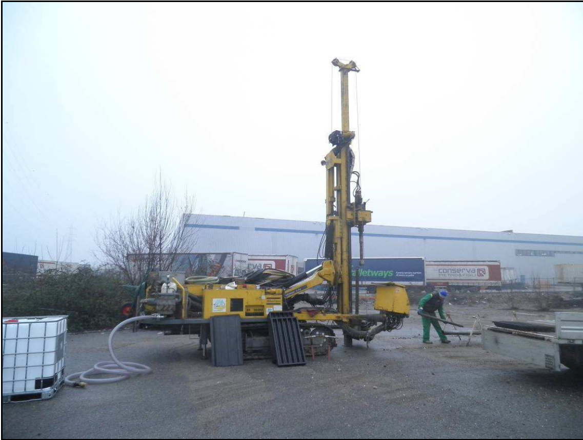
Postazione sondaggio S1.
