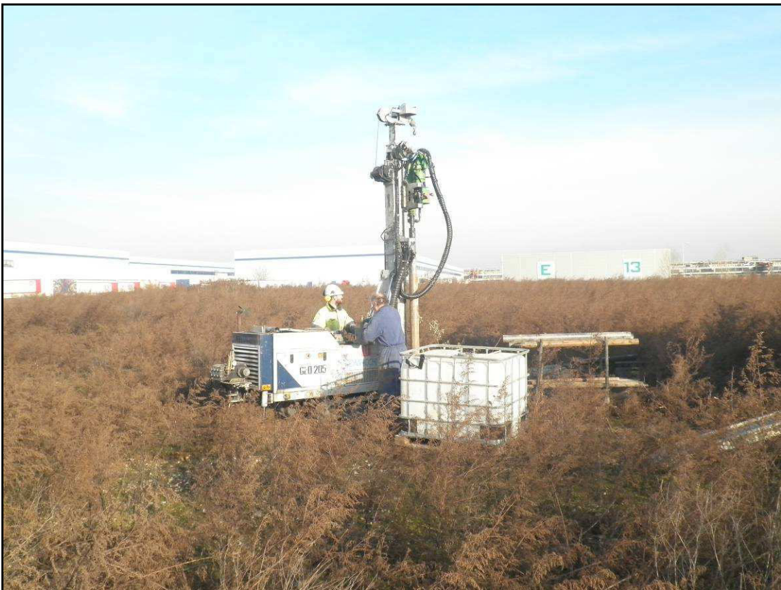
Postazione sondaggio S4.
