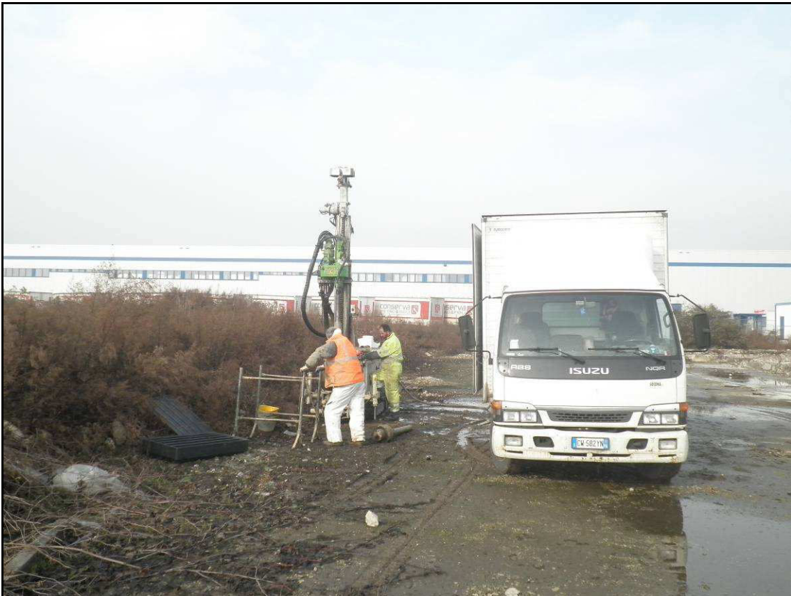
Postazione sondaggio S6.
