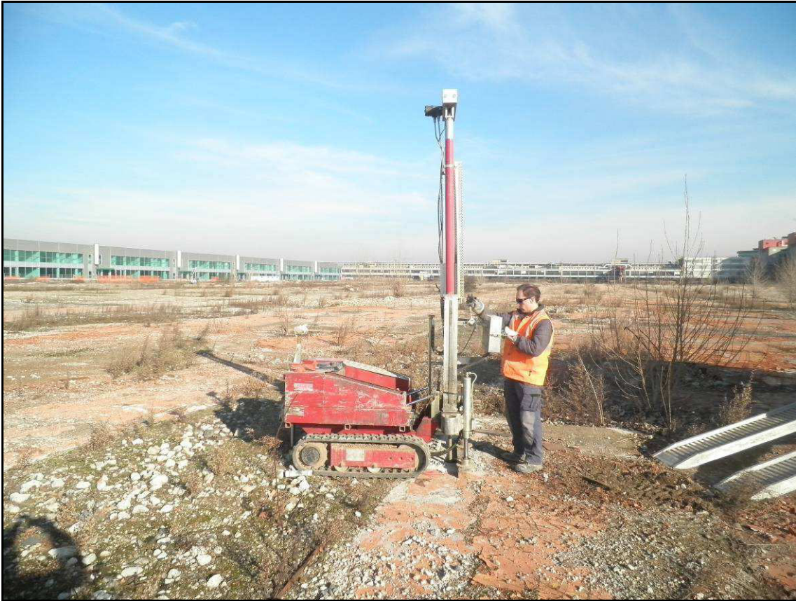
Postazione prova penetrometrica DP1.
