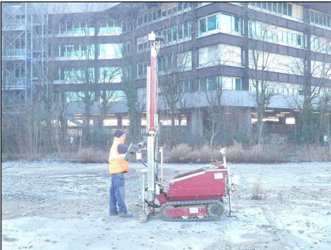
Postazione prova penetrometrica DP21.
