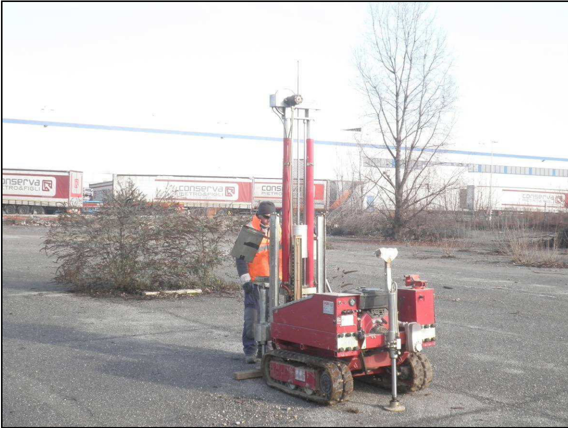
Postazione prova penetrometrica DP1.
