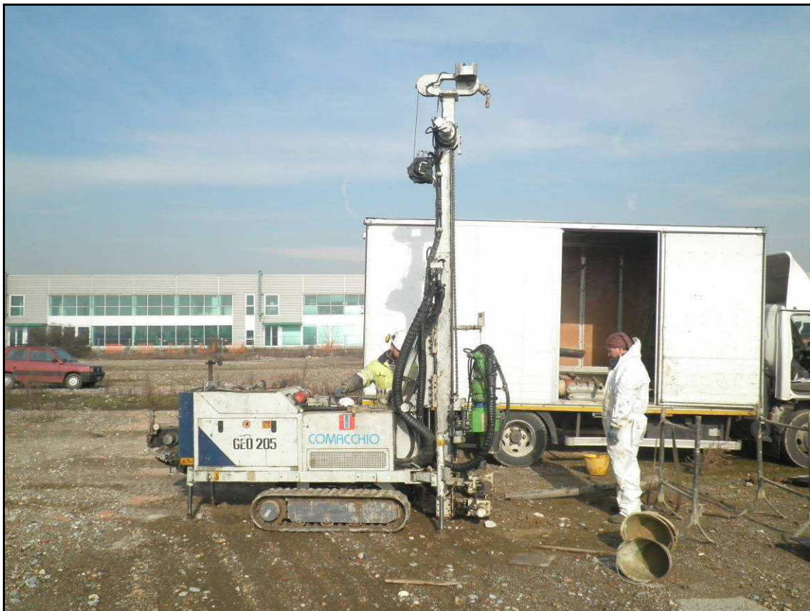
Postazione sondaggio S7.
