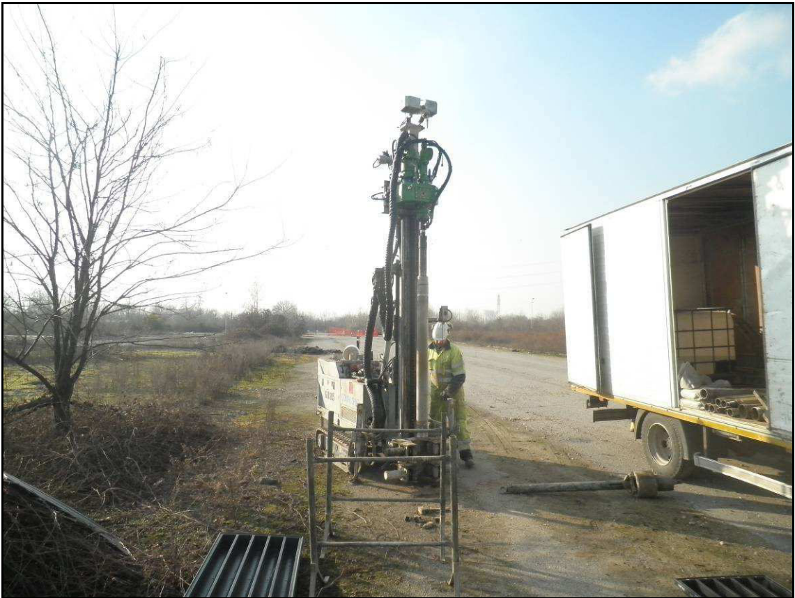
Postazione sondaggio S5.
