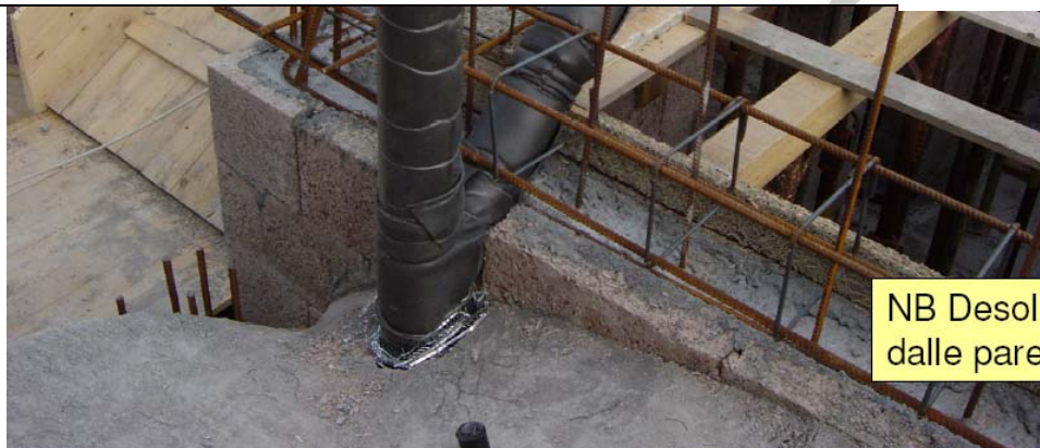
Esempio di isolamento in opera di un tratto di tubazione
