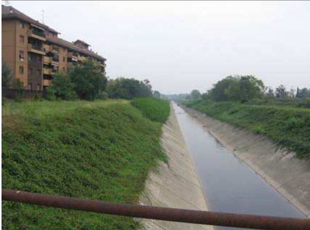
Fig. 29 Il canale scolmatore
