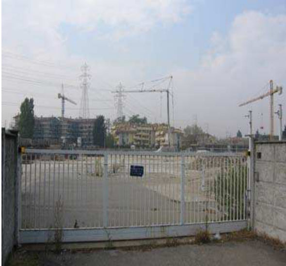
Fig. 18 Trasformazioni in corso
