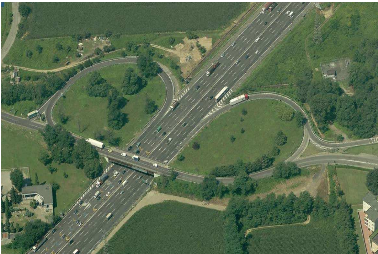
Fig. 3 Lo svincolo di Arese sull'A8 Milano-Laghi
