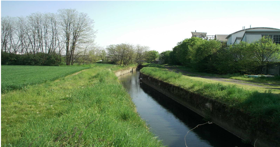
Fig. 78 – Torrente Guisa in Via Vismara vista sud
