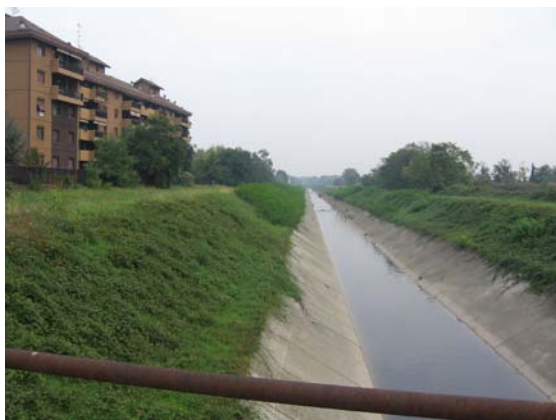
Fig. 29 Il canale scolmatore
