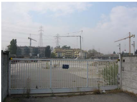
Fig. 18 Trasformazioni in corso
