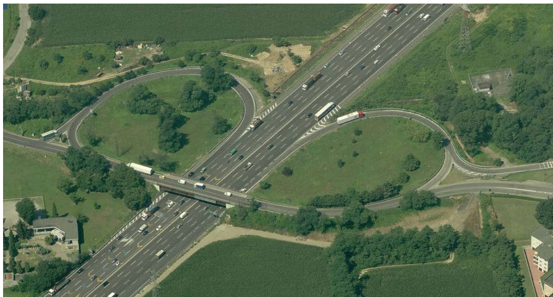
Fig. 3 Lo svincolo di Arese sull'A8 Milano-Laghi
